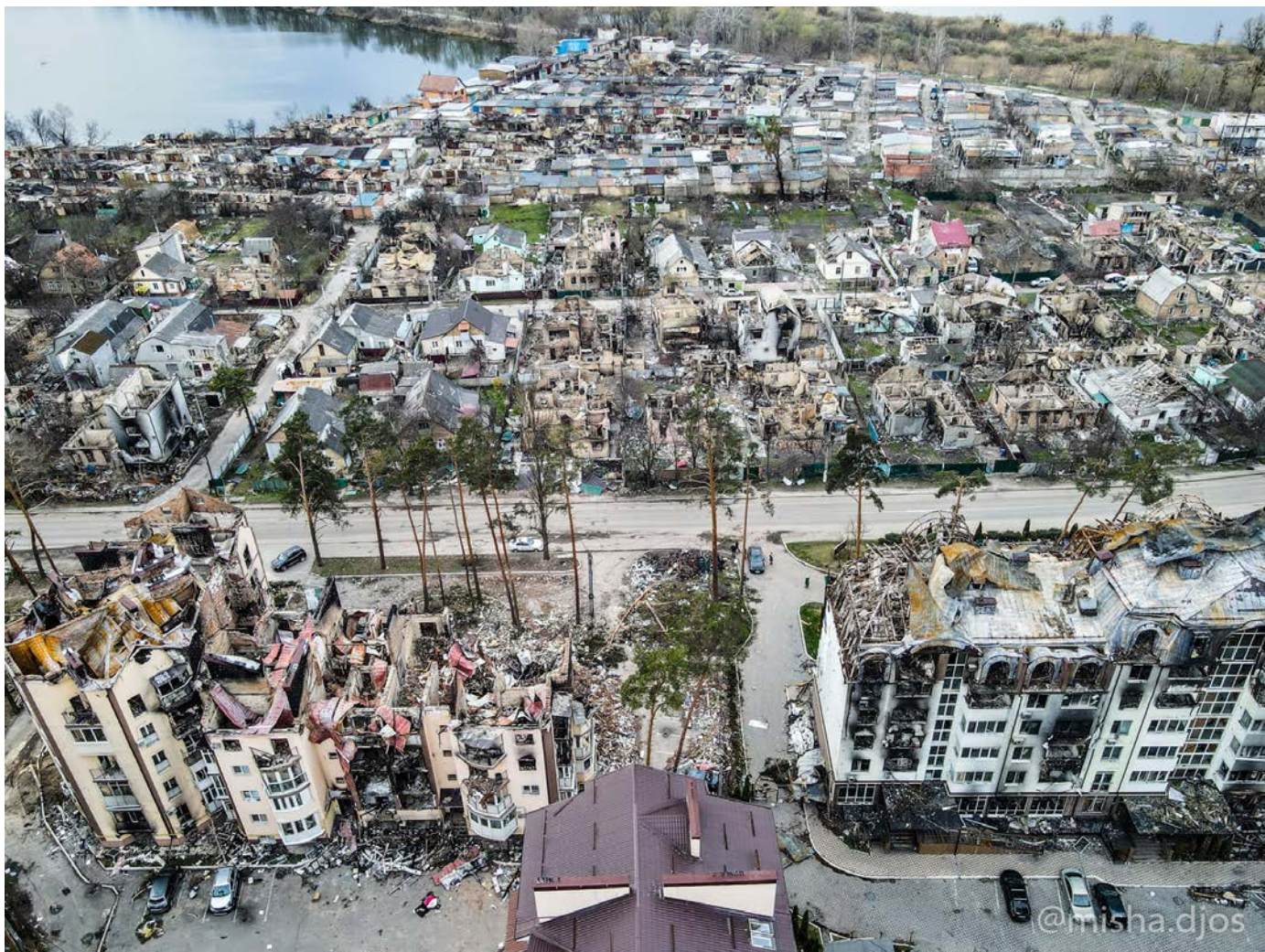
Ірпінь. Зруйнований приватний сектор
