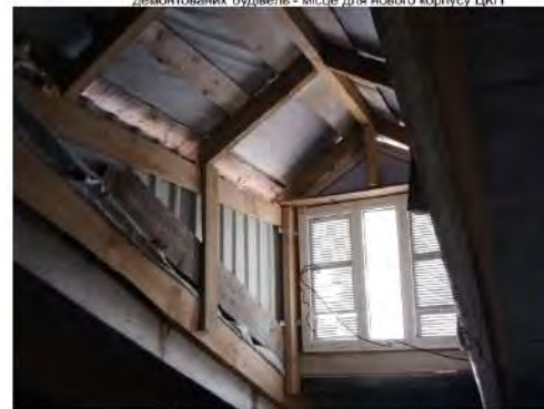
Слухове вікно на горищі слухові вікна та інші світлопрозорі конструкції й проходи інженерних мереж мають негерметичні примикання, що погіршує енергоефективність будівлі зцілому
