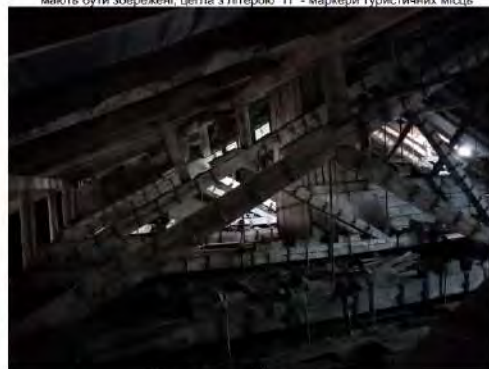
Конструкції горища дерев'яні конструкції горища не мають біо-та вогне захисту, утеплення горища не відповідає нормам ДБН
