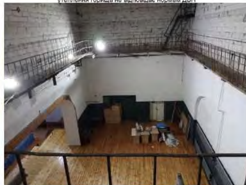
Вид на сцену з технічного мосту потрібна заміна демонтованих колосників
