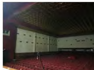
велика зала сакція зовнішніх огорожуваних конструкцій, перевоснащення системи опалення та вентиляції, пожежної сигналізації, димовидалення, удосконалення інтер'єру
