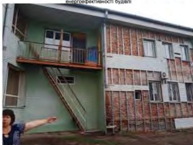
дворовий фасад та простір двору пошкоджені ураганом секцій на фасаді без утеплення стін, пустір у дворі, прибудована драбина на 2й поверх
