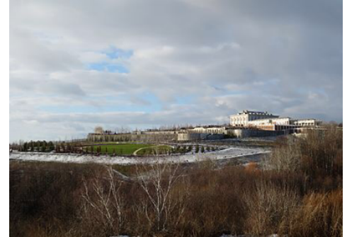
Резонансная постройка на Хотовском городище скифских времен
